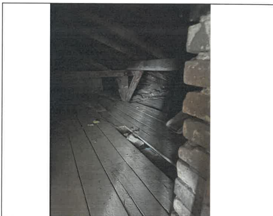
Fig. 10 – Planseu lemn peste parter – zona pod
