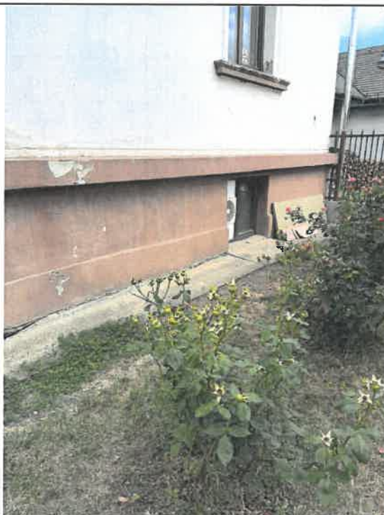
Fig. 2 Degradari soclu
